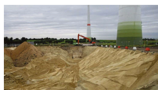
Während der Rekultivierungsarbeiten
