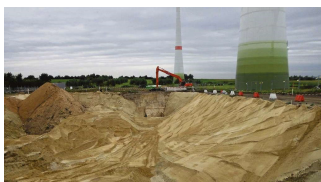
Während der Rekultivierungsarbeiten
