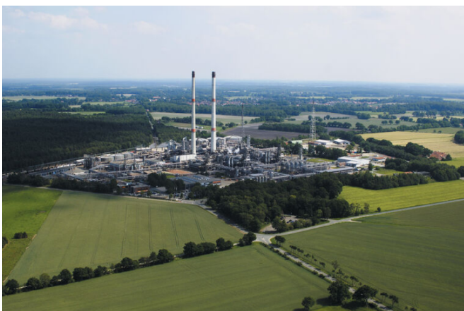
Erdgasaufbereitungsanlage in Großenkneten
