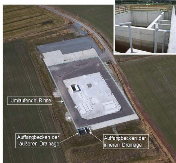
**Abb. 4: Bohrplatz für eine Erdgas-Tiefbohrung**
