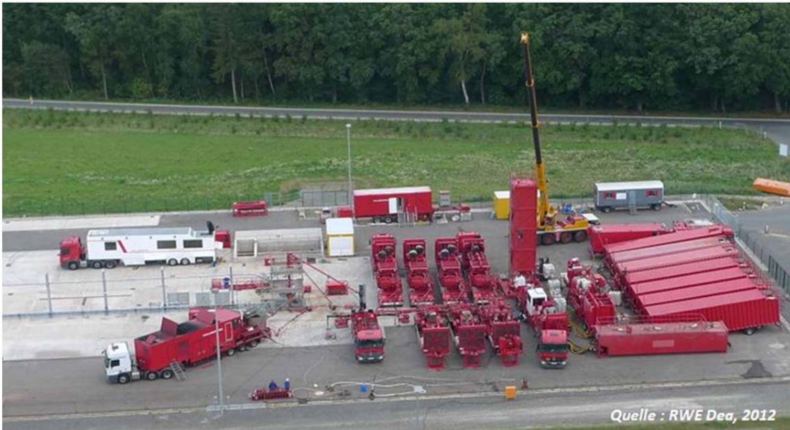
**Abb. 8: Durchführung einer hydraulischen Bohrlochbehandlung**
