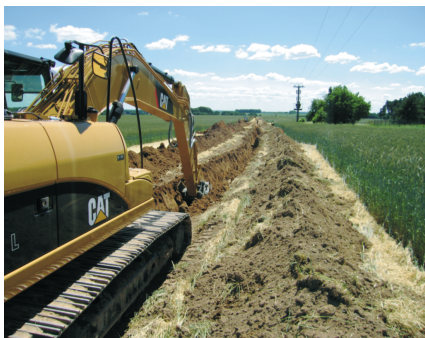
Der Rückbau einer Leitung
