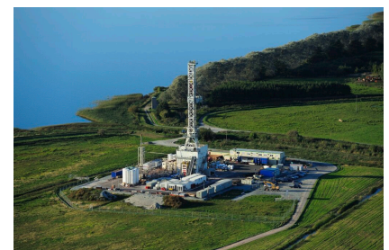
Bohranlage auf Usedom
