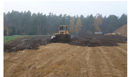
Beim Aufbringen von Mutterboden
