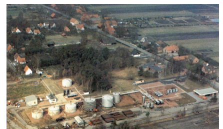
Während der Betriebszeit (aus östlicher Richtung)
