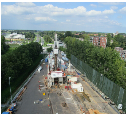
Für den Rückbau untertage wird eine geeignete Anlage benötigt © Drilltec
